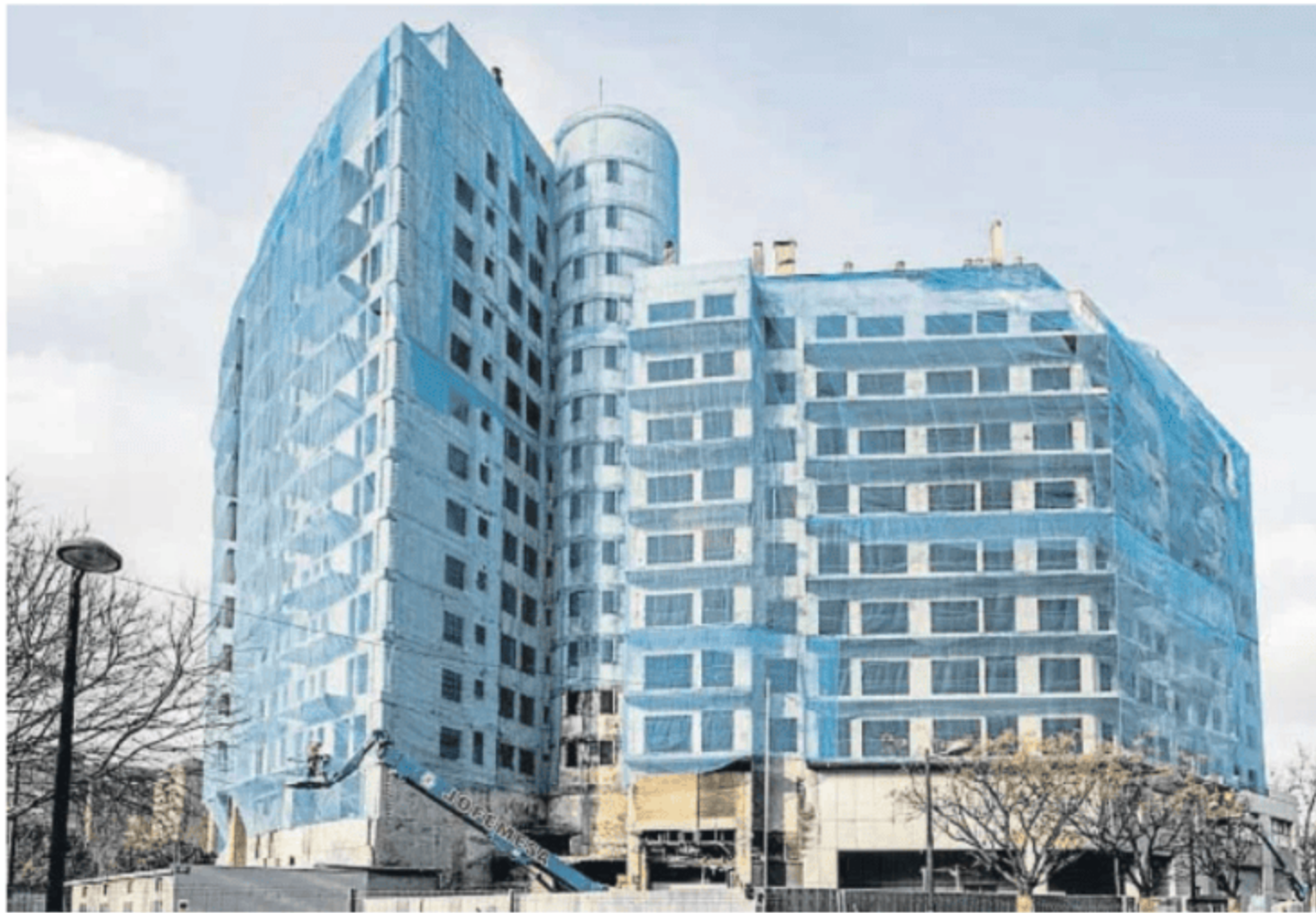
Una malla protectora recubre el edificio mientras se trabaja en su rehabilitación
